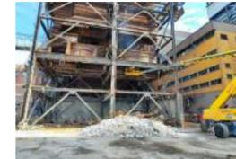
**Demolición y desmantelamiento del Grupo 2, con la dificultad añadida de que el resto de la central sigue en funcionamiento.**
